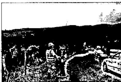
Foto E. 5: Manejo de señalización para el flujo vehicular
